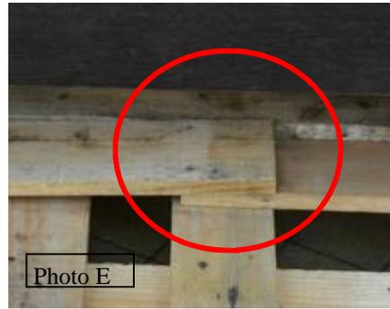
4. Glisser une seconde planche de déchargement (photo D) en face de la première. **TRES IMPORTANT:** Bien veiller à ce que la seconde planche se superpose avec la première (photo E)
